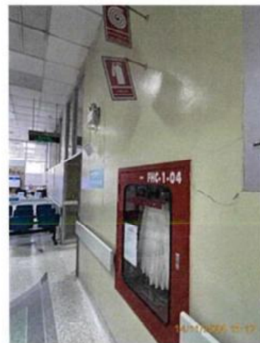
ภาพถ่ายที่ 2.2-30 อุปกรณ์เตือนภัยและป้องกันอัคคีภัยของโครงการ
